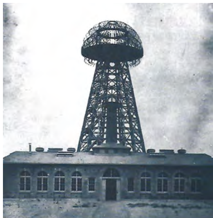
Obr. 5: Teslova vysílací stanice na Long Islandu v USA s vysílací věží vysokou 57 metrů určená pro přenos radiového vysílání i silové elektřiny, její výkon byl 1 500 kW
